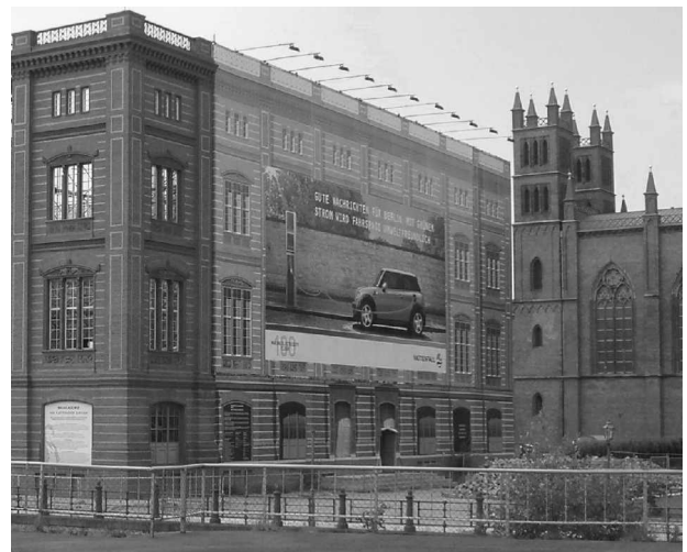
Musterfassade (links in der Abbildung) und Nordseite der Schauffassade, rechts: Friedrichswerdersche Kirche Foto: Wolfgang Schoele (2009)
